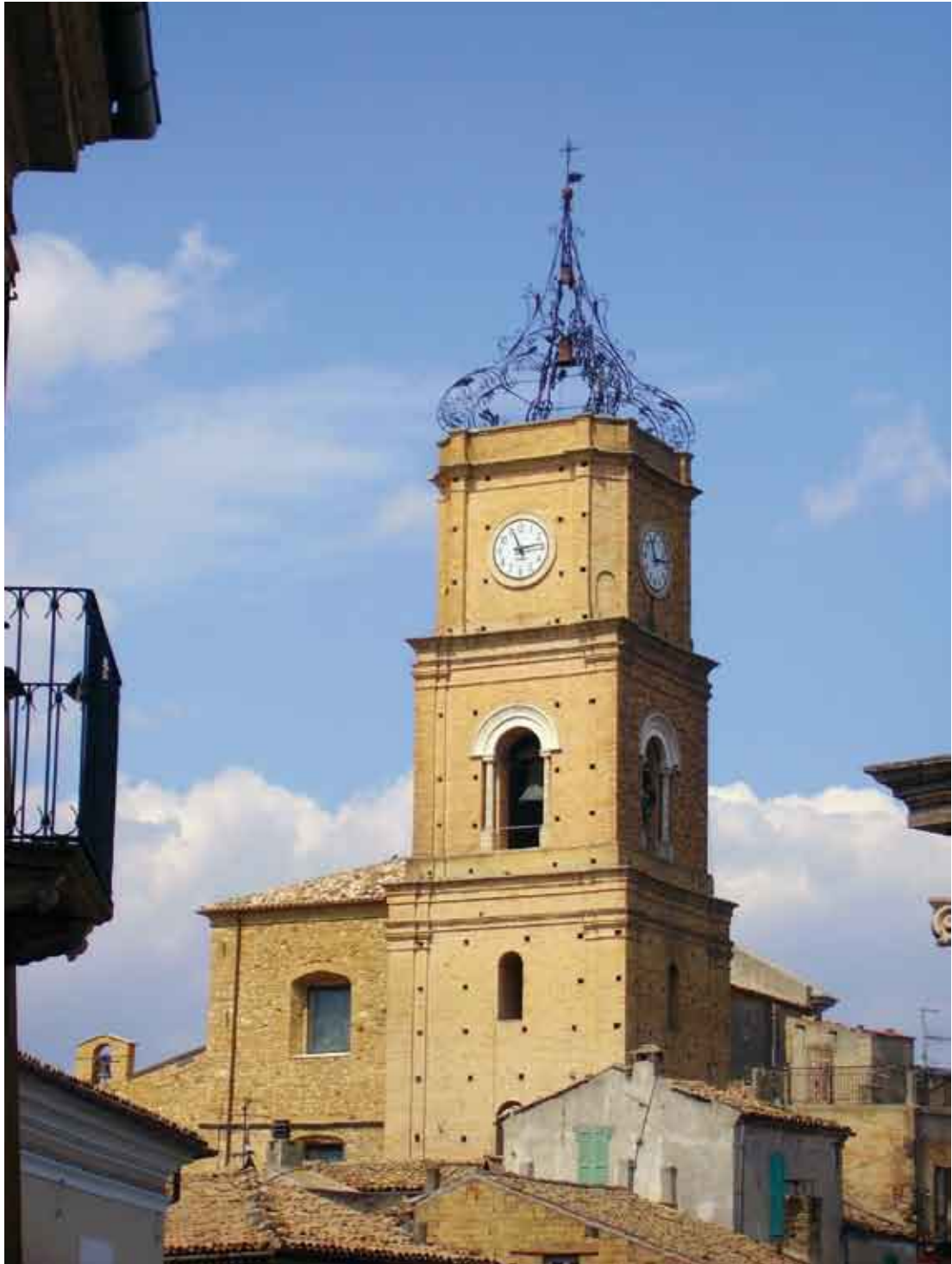
Il nuovo campanile, alto 41 metri, sormontato dal castello di ferro battuto del maestro artigiano Umberto Nasuti di Atesa.
