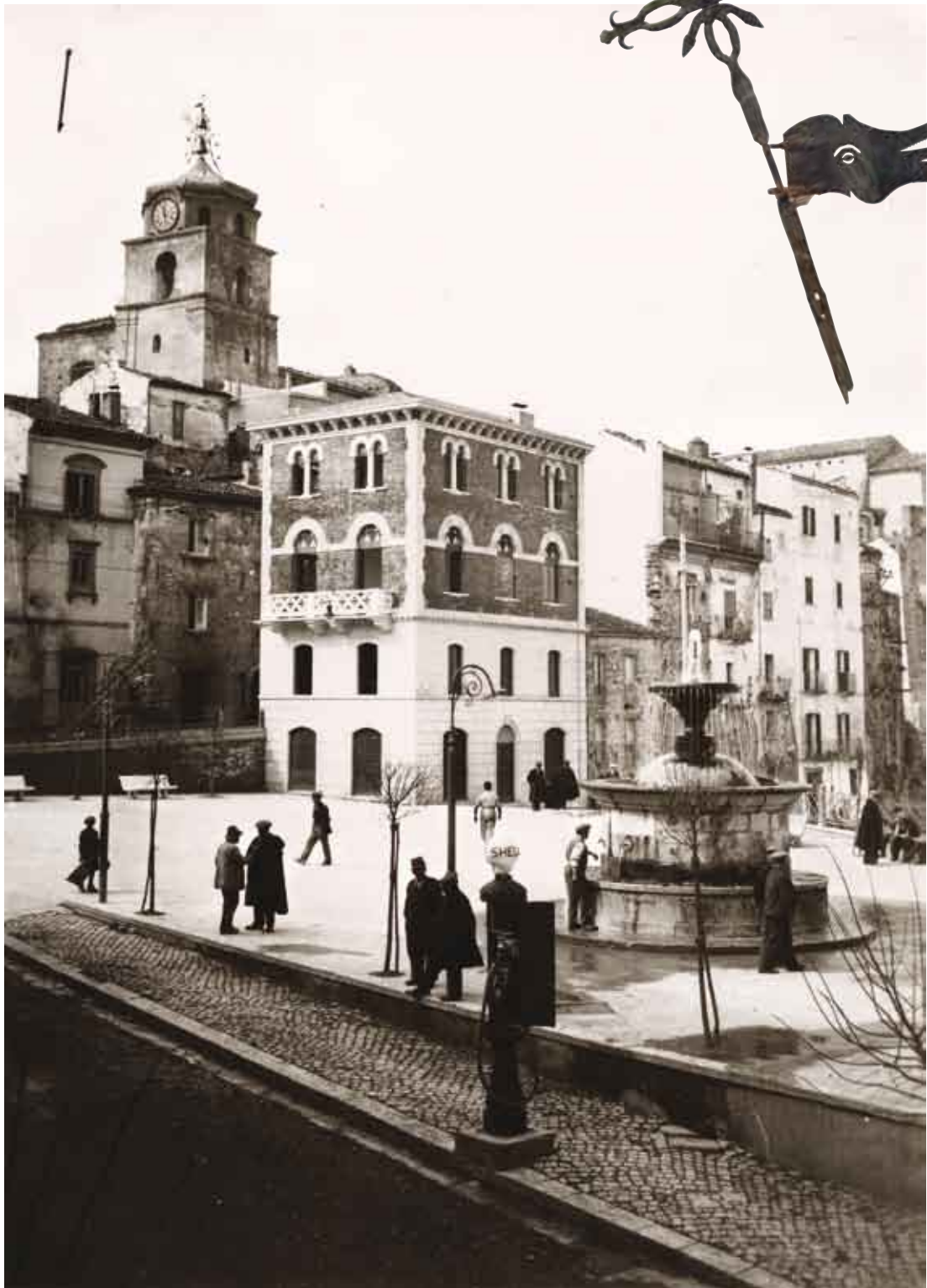
Il vecchio campanile della Cattedrale di S. Leucio, alto 35 metri, eretto nel XVIII secolo per volontà del prevosto Giandionisio Maccafani. In alto, a destra: il segnamento del campanile.
