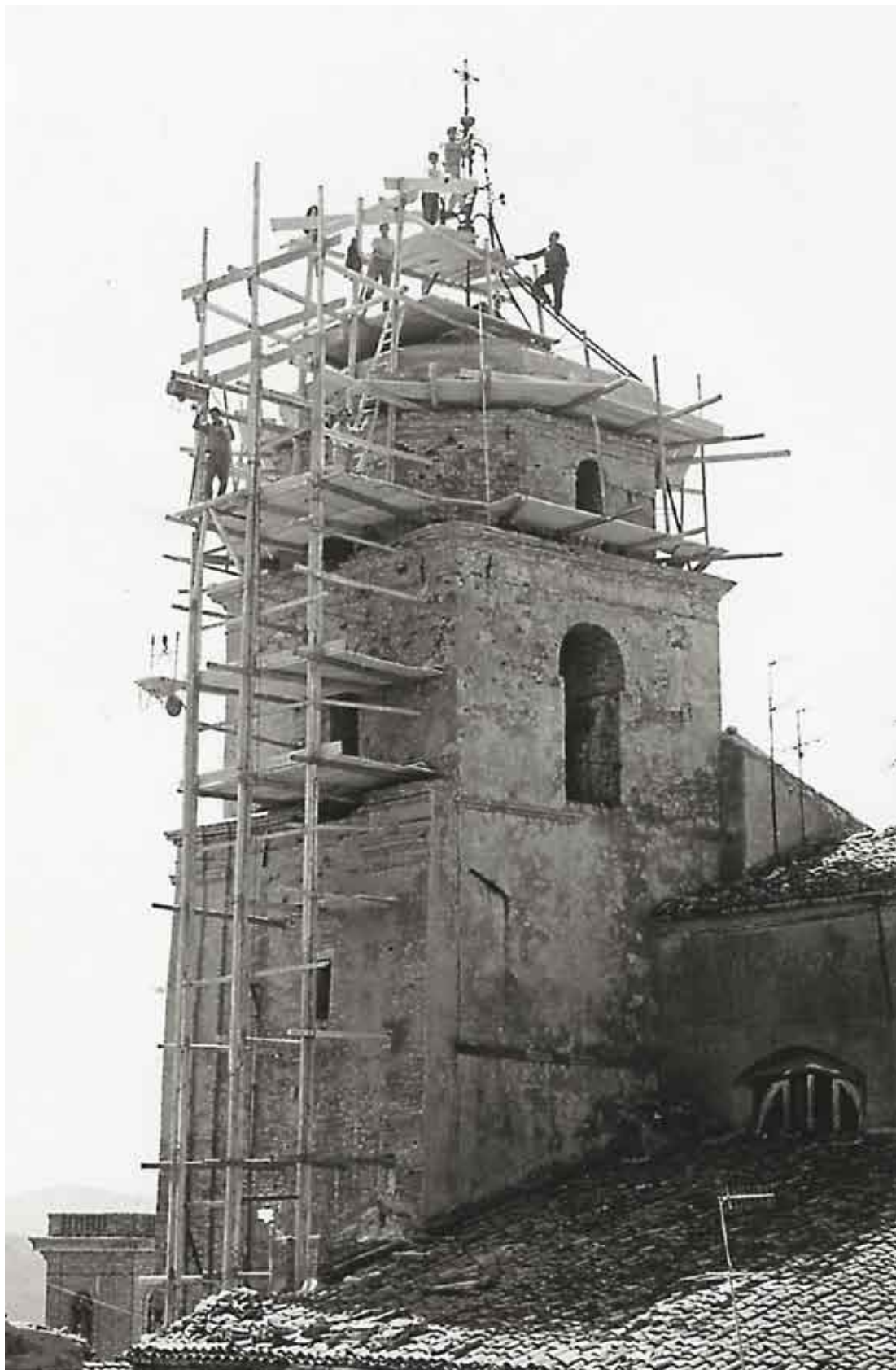
Lavori di rifacimento del campanile, eseguiti negli anni 1962 e 1963 dalle imprese cittadine “Antonio Farina” e “Celestino Pellegrini”, associatesi per l’occasione. L’opera si rese necessaria a causa dei gravi danni cagionati al vecchio campanile dalle vicende belliche dell’autunno 1943, oltre che dall’azione demolitrice del tempo.
